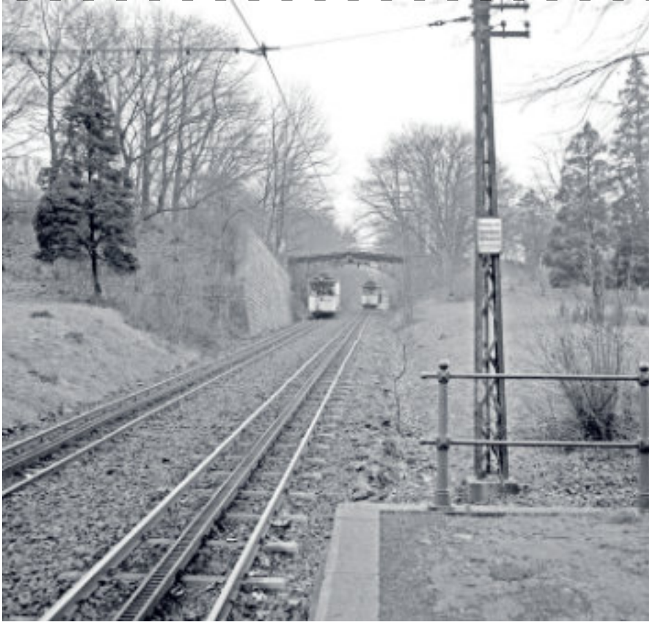
Unter der so genannten „Spuckbrücke“ begegnen sich zwei Bergbahnwagen mit offener Plattform. Dieser Teil der Strecke ist heute mit der Stützwand unter der Hangaufschüttung verschwunden.
